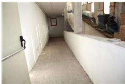
Rampa accesso interrato
